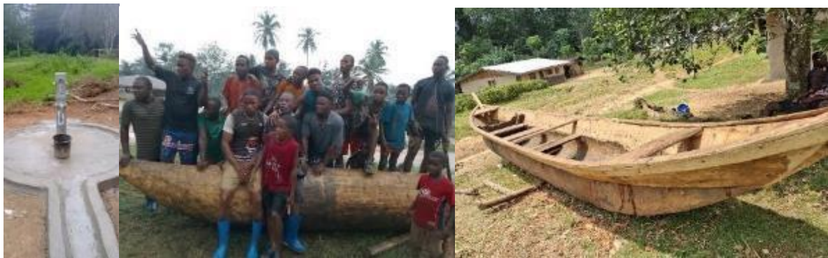
Nouvelle pompe manuelle construite à Chewlue, SNP (à gauche) et nouvelle pirogue pour le district de Tarjuowon/PKNP (au centre et à gauche), pour assurer la traversée en toute sécurité de la rivière Sanquin.
