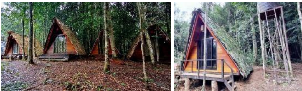
Le Sapo Ecologie agrandi comprend désormais six chambres indépendantes, un nouveau système solaire, une plateforme de restauration agrandie et une plateforme supplémentaire pour les tentes.
